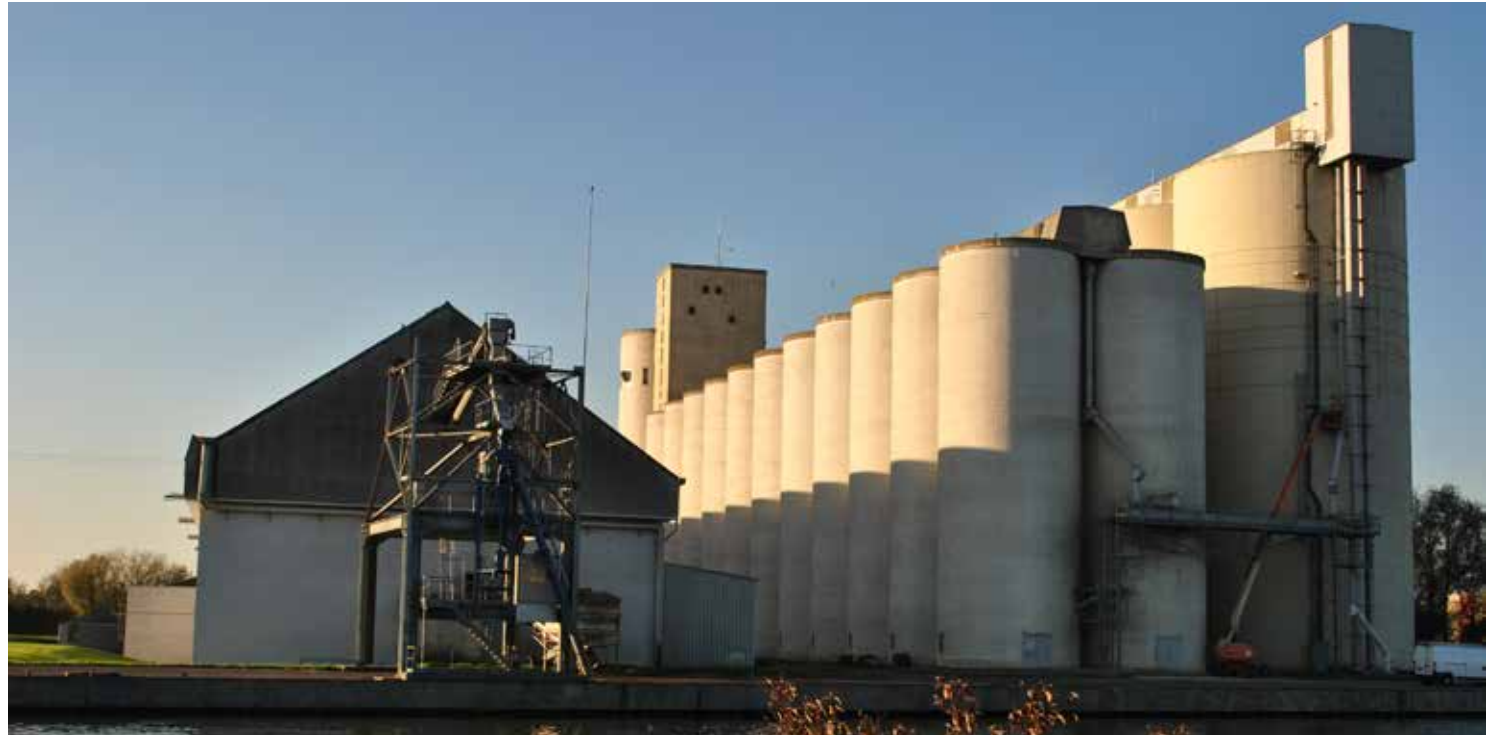
Vue sur le silo Invivo, photographie personnelle
