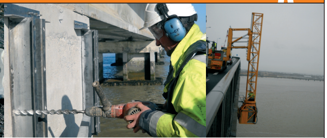
Travaux de perçage pour fixation des portiques de signalisation
