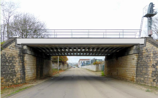
Remplacement des accotements afin de respecter la réglementation SNCF
