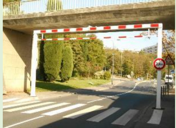
Mise en place de portiques de limitation de gabarit
